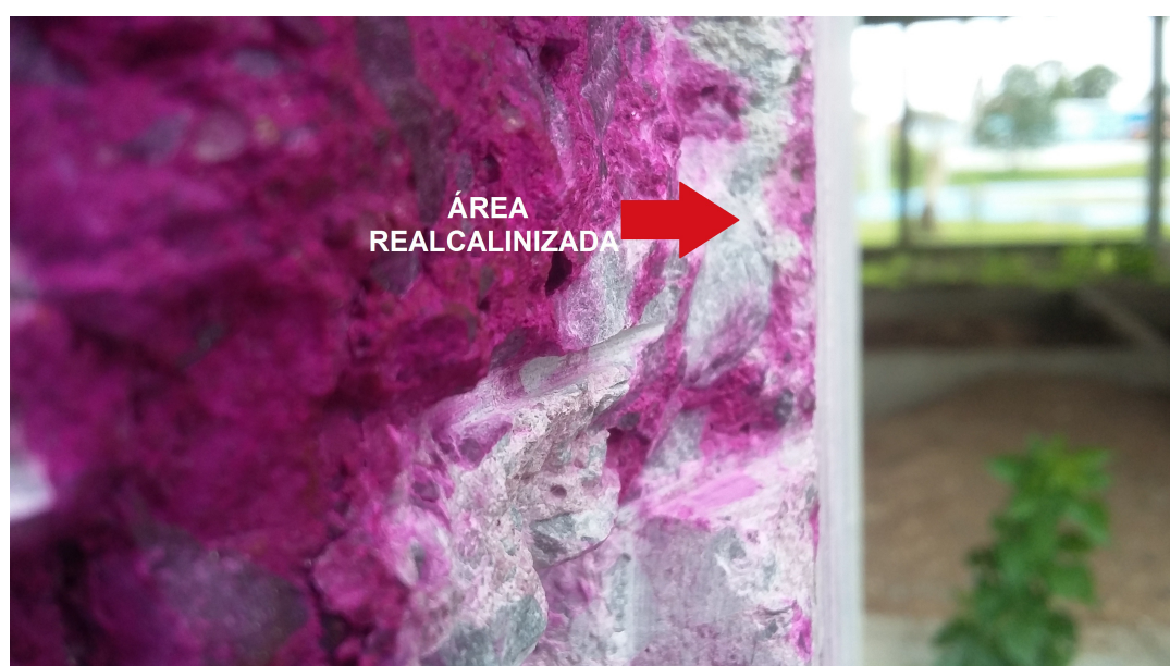
FIGURA 64 – Realcalinização no pilar P17, tratado com manta embebida em solução de KOH.
