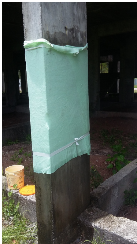
FIGURA 32 – Pilar envolt com manta umedecida em solução alcalina. FONTE: A autora.
