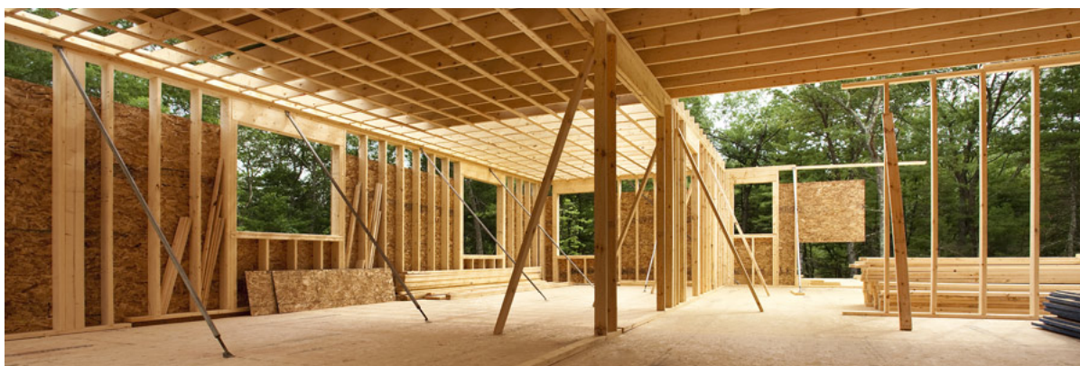
FIGURA 42 - Canteiro de obras de uma construção em wood frame
