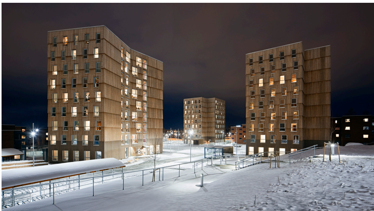
FIGURA 48 - Torres de Madeira Moholt em Trondheim, Noruega, executadas em CLT. Projeto de MDH Arkitekter
