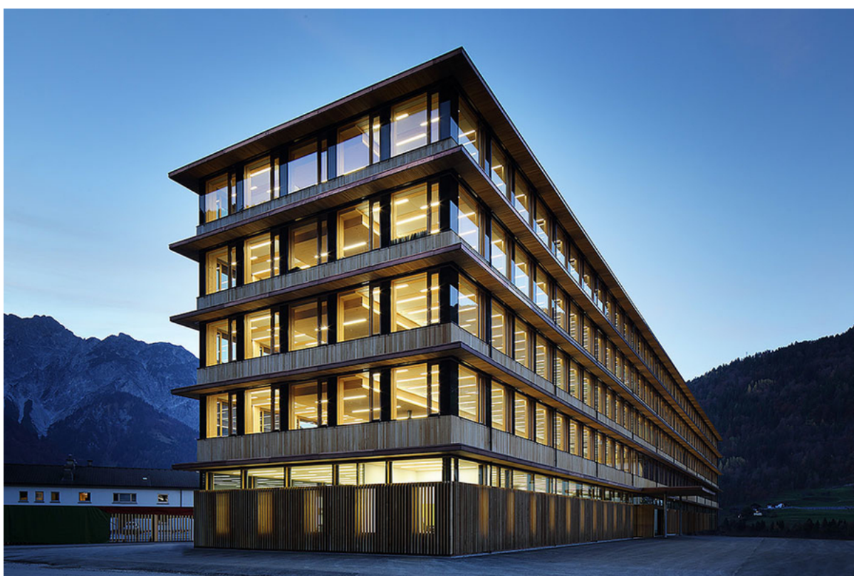
FIGURA 45 - Edifício Illwerke Zentrum Montafon em Vandans, Áustria. Projeto de Architekten Hermann Kaufmann
