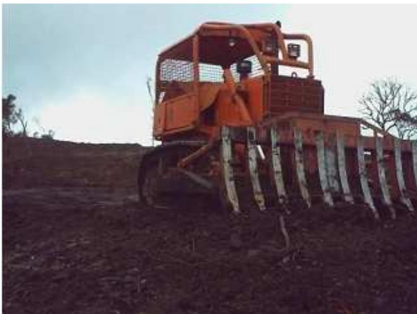
FIGURA 20 - LIMPEZA DO TERRENO UTILIZANDO UM TRATOR DE ESTEIRA COM GRADE
