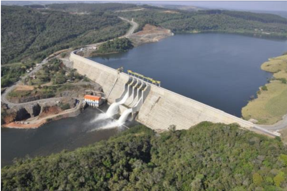
Foto aérea da UHE Mauá em operação parcial das turbinas geradoras, em 12/12/2012
