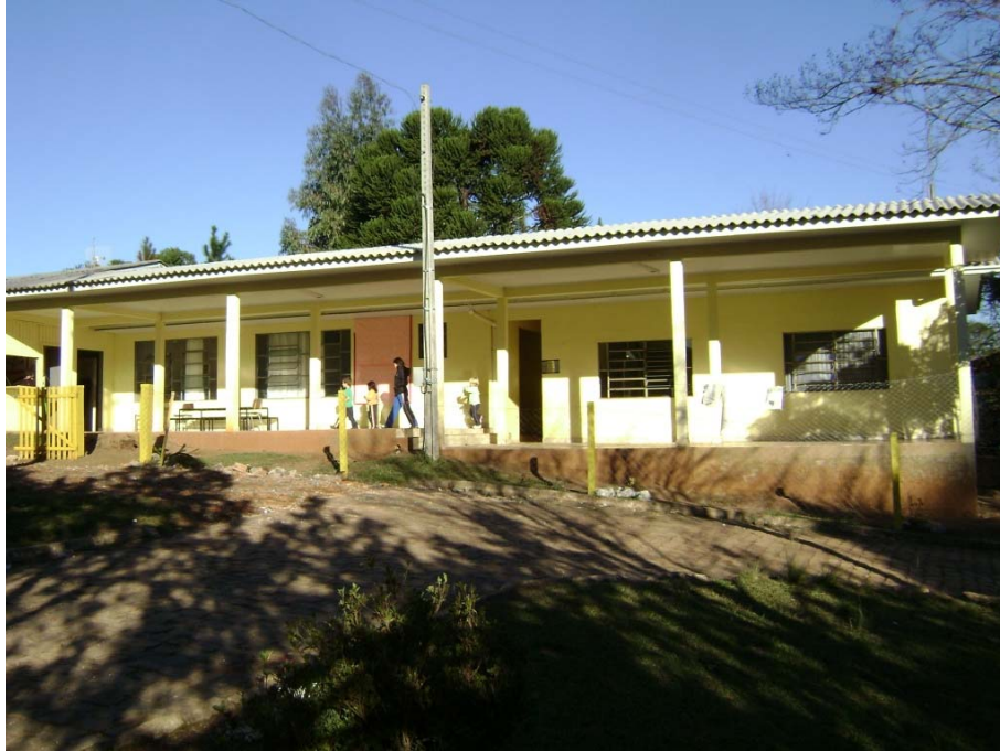
FIGURA 38 - ESCOLA DA COMUNIDADE SÃO PEDRO FONTE: ENGEMIN (2012)
