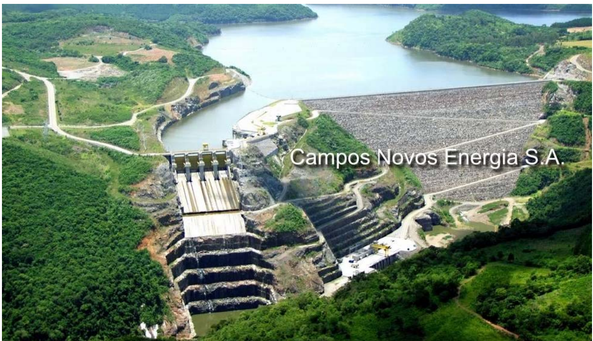
FIGURA 27 - IMAGEM DA HIDRELÉTRICA CAMPOS NOVOS, SITUADA ENTRE CAMPOS NOVOS E CELSO RAMOS FONTE: ENERCAN (2012)
