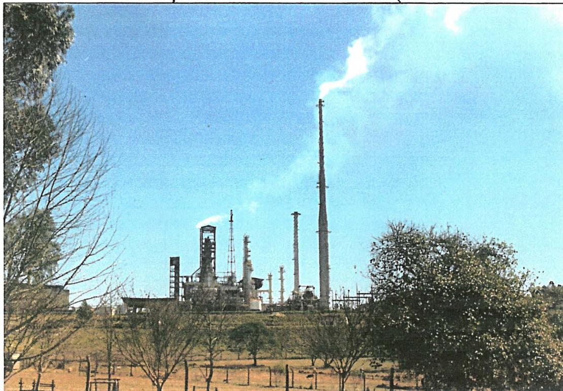
FOTO 2 - VISTA GERAL DA FRENTE DE LAVRA, NOTANDO-SE AO FUNDO A ESCAVADEIRA TIPO DRAGLINE UTILIZADA PARA A REMOÇÃO DO CAPEAMENTO E DA CAMADA INTERMEDIÁRIA
