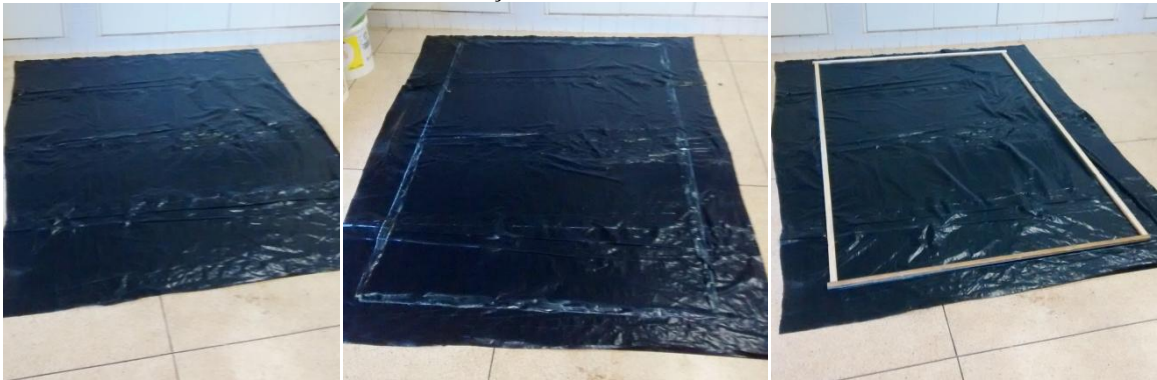
FIGURA 3.36 - CONFEÇÃO DAS FORMAS PARA AS PLACAS
