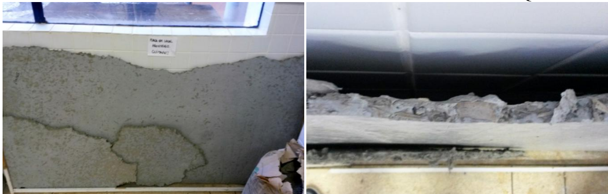
FIGURA 3.27 – DETALHE DA PLACA COM COMPÓSITO DE CIMENTO-MADEIRA QUEBRADA
