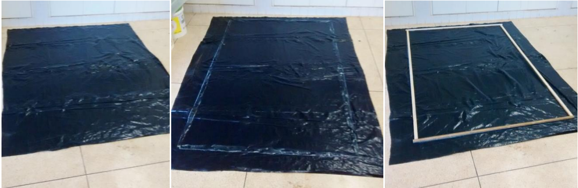
FIGURA 3.23 - CONFEÇÃO DAS FORMAS PARA AS PLACAS
