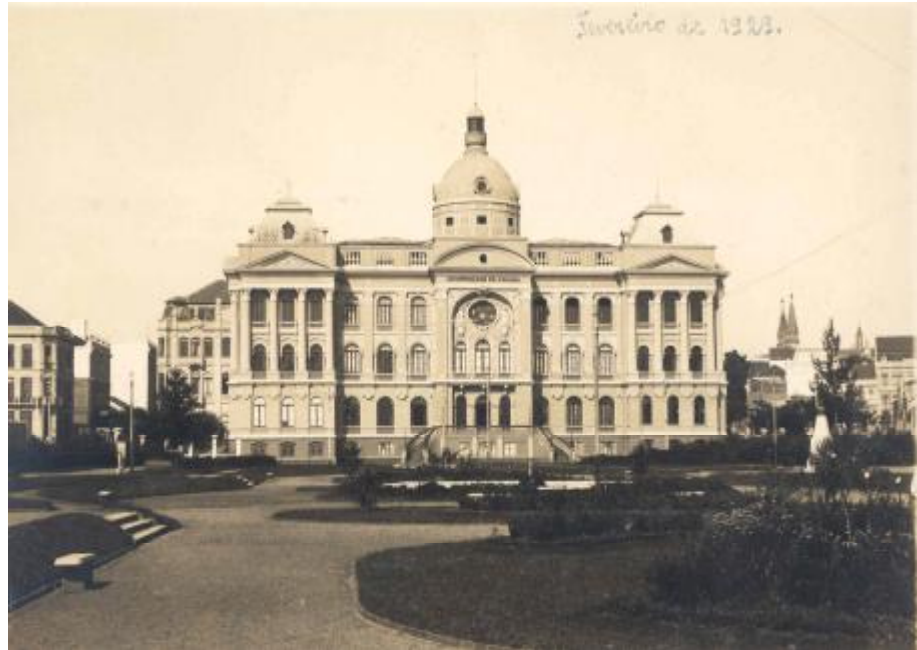
FOTO 3 – EDIFÍCIOS: PRÉDIO DA UNIVERSIDADE DO PARANÁ.
