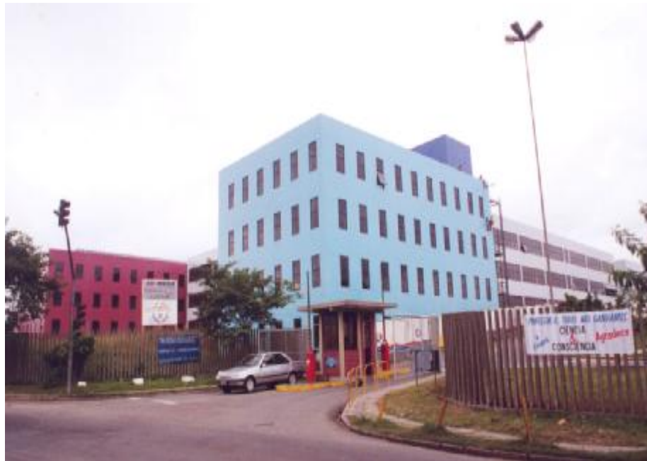
FOTO 8 – EDIFÍCIOS: SETOR DE CIÊNCIAS SOCIAIS APLICADAS
