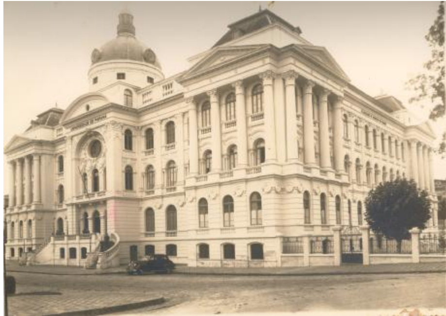
FOTO 5 – EDIFÍCIOS: PRÉDIO DA UNIVERSIDADE DO PARANÁ
