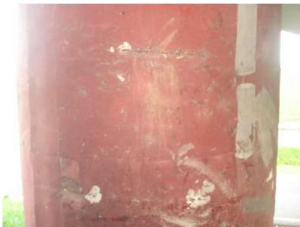
Figura 17 - Corrosão da armadura com deslocamento de concreto
