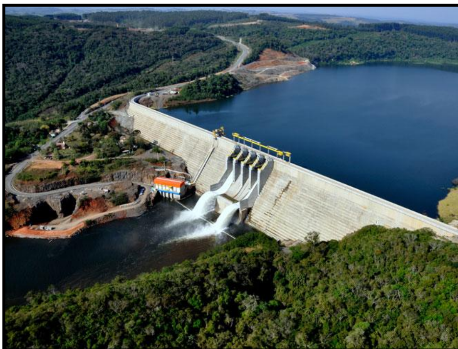
Figura 2. Barragem e trecho do reservatório da UHE Mauá, no rio Tibagi, estado do Paraná, Brasil. Fonte: COPEL, 2013.
