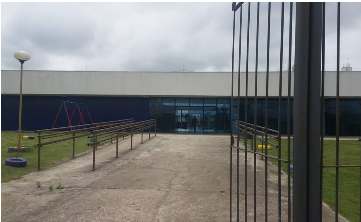
FIGURA 15 – FACHADA DA UNIDADE PORTAL DO FUTURO CAJURU
