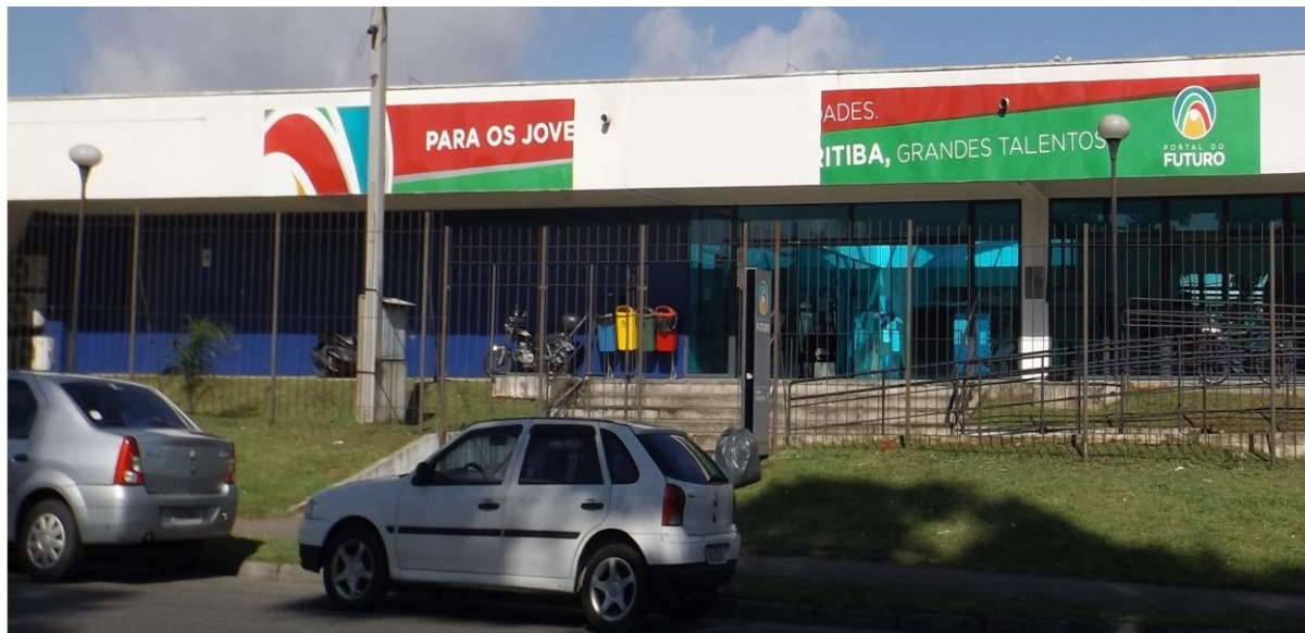
FIGURA 07 - ENTRADA DA UNIDADE PORTAL DO FUTURO BOQUEIRÃO
