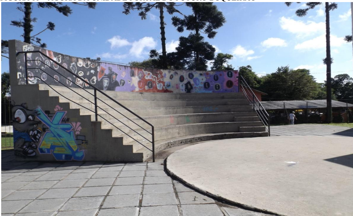
FIGURA 10 – ÁGORA DA UNIDADE PORTAL DO FUTURO BOQUEIRÃO
