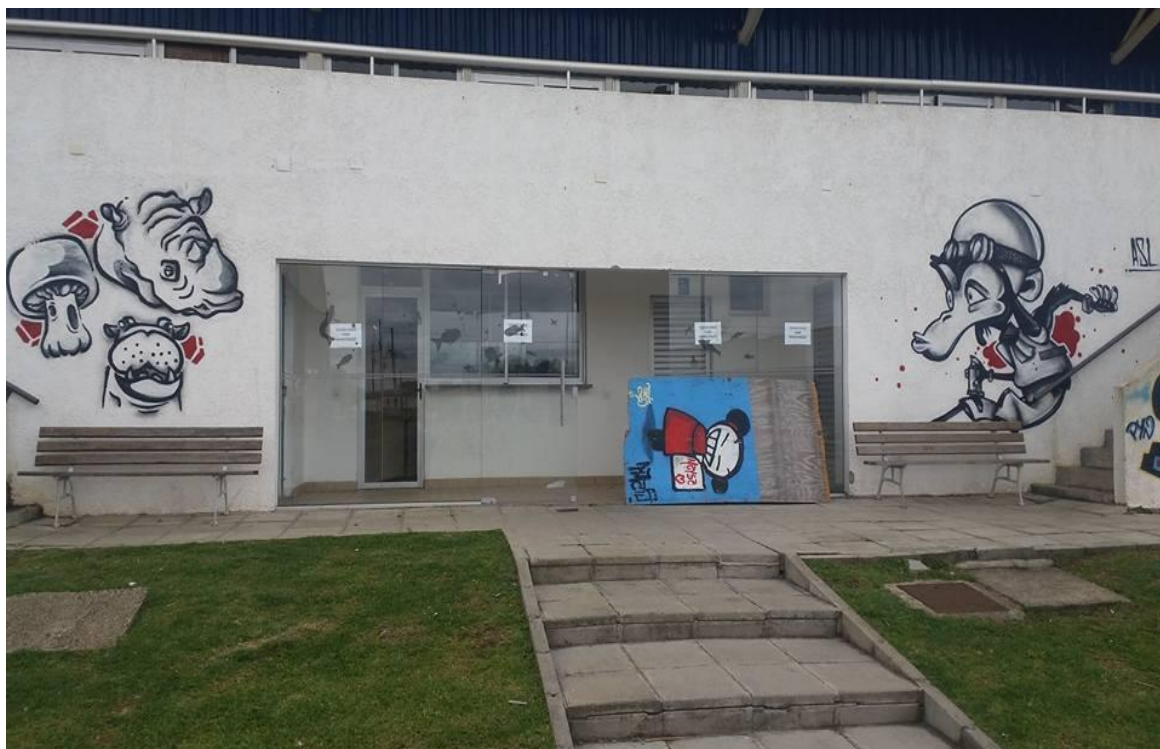
FIGURA 25 - ENTRADA DA PSICINA DA UNIDADE PORTAL DO FUTURO CAJURU
