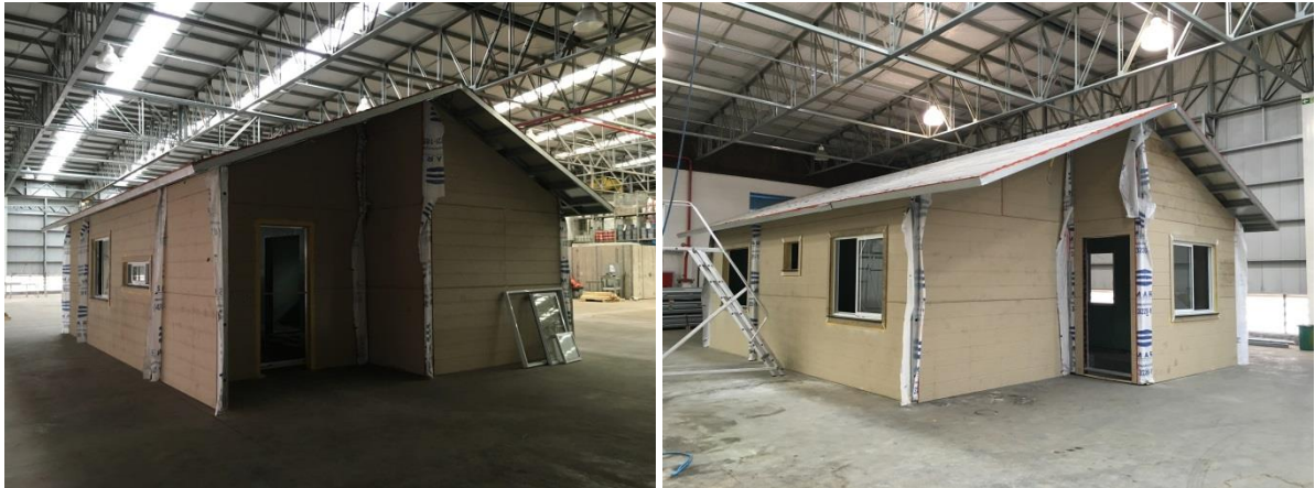
Figuras 27 e 28 – Residência de LSF pré-montada em fábrica para testes: vistas externas
