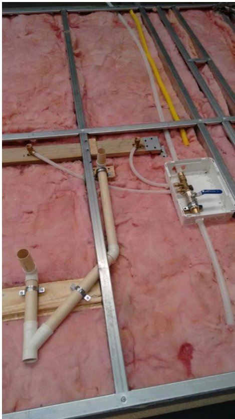
Figuras 25 e 26 – Instalação das tubulações embutidas e fixação das chapas internas
