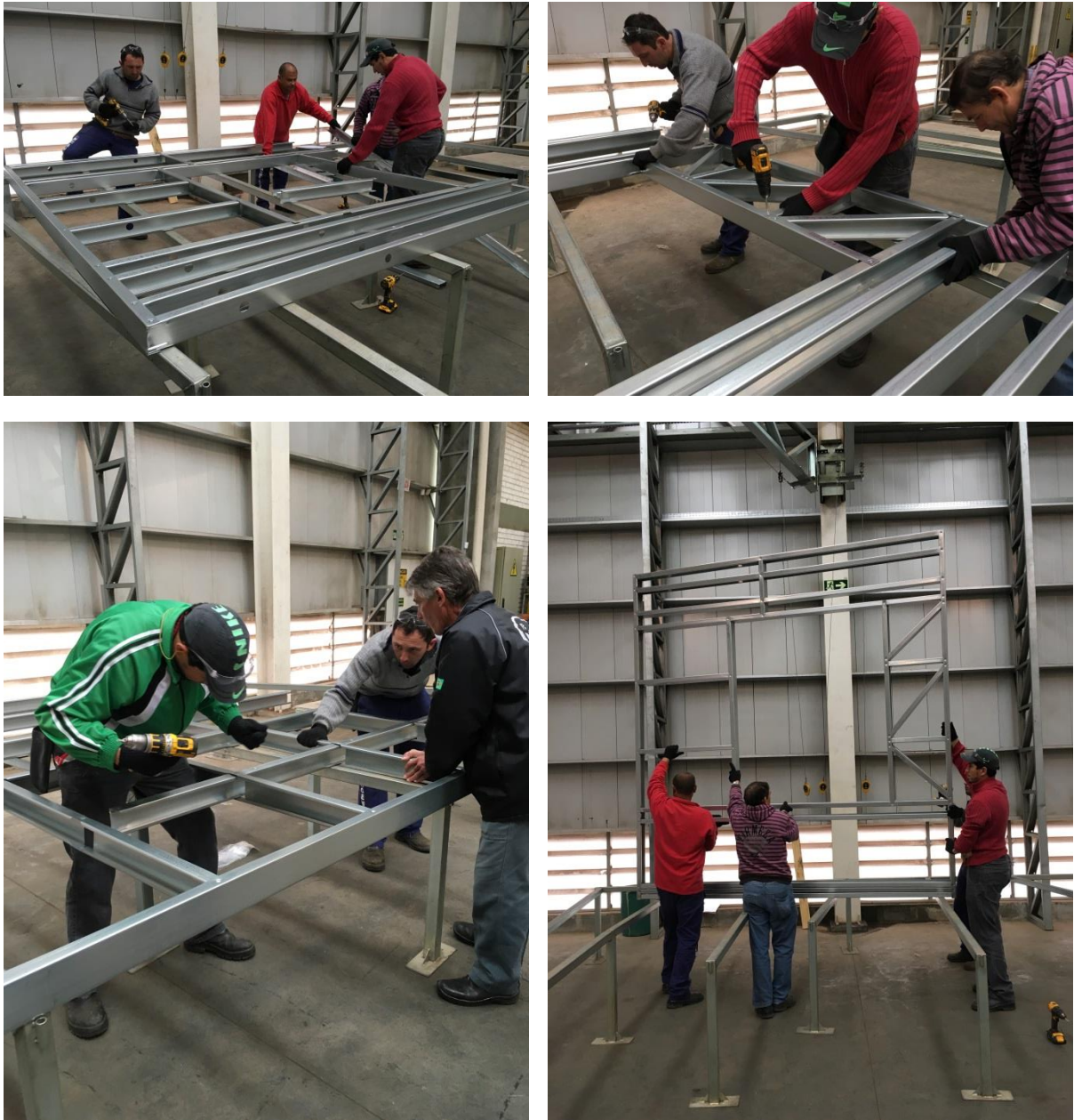
Figuras 17, 18, 19 e 20 – Montagem da estrutura de aço dos painéis, conforme projeto
