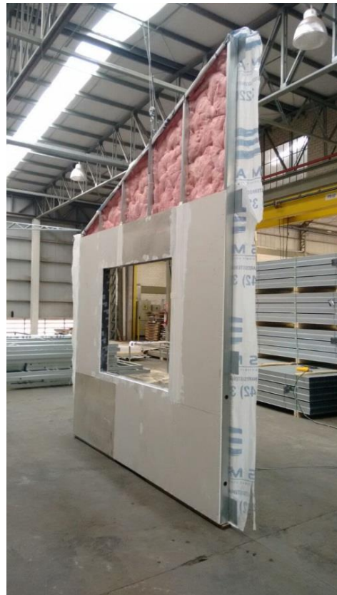
Figuras 25 e 26 – Instalação das tubulações embutidas e fixação das chapas internas
