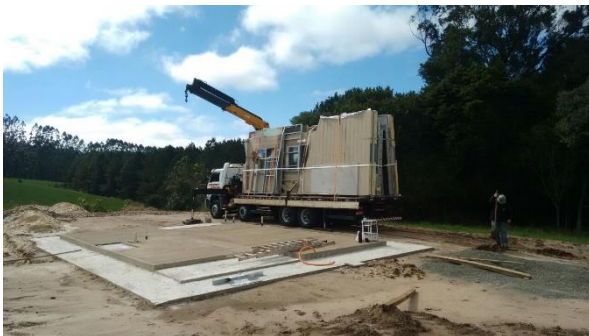
Figuras 41, 42, 43, 44, 45 e 46 – Descarregamento e montagem dos painéis na obra
