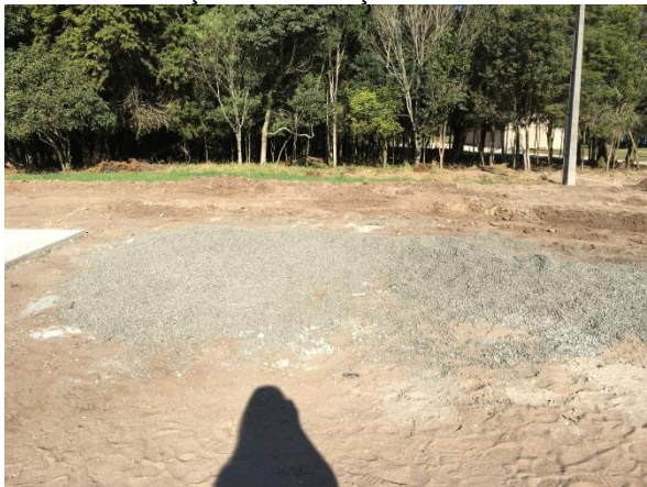
Figura 49 – Resíduos de brita gerados na execução da fundação em radier
