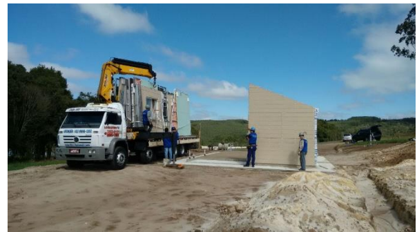
Figuras 41, 42, 43, 44, 45 e 46 – Descarregamento e montagem dos painéis na obra
