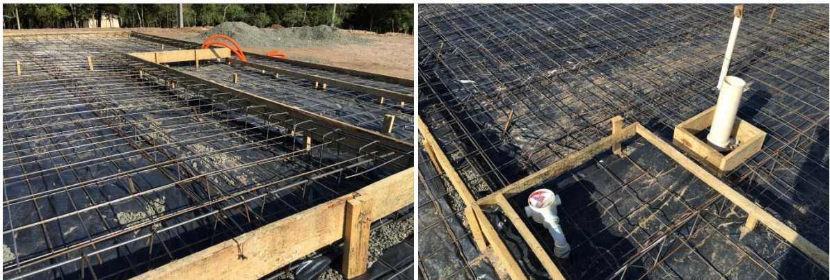
Figuras 35 e 36 – Concretagem do radier
