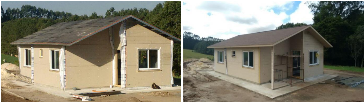
Figuras 47 e 48 – Residência montada, com e sem telhas
