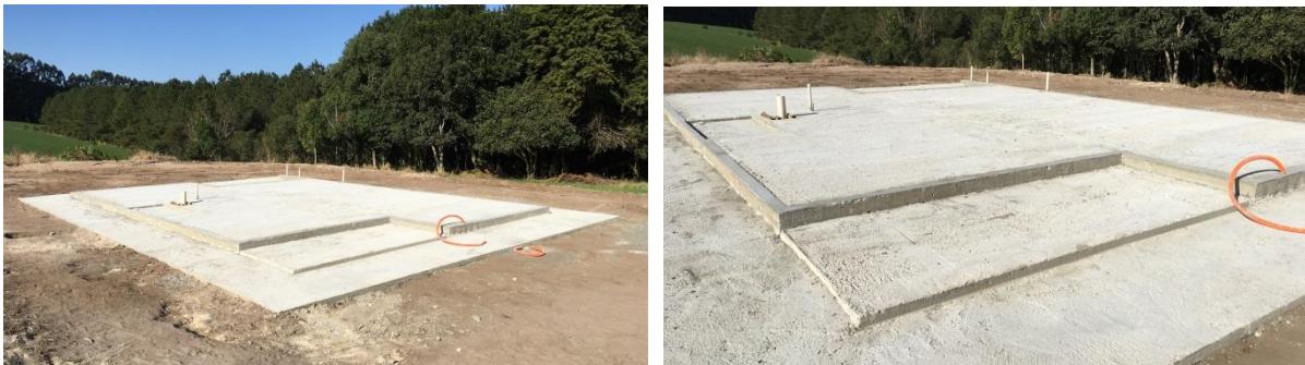
Figuras 37 e 38 – Radier e calçada já concretados e desenformados
