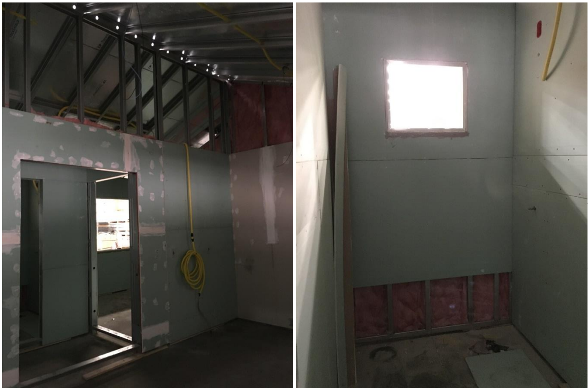
Figuras 29 e 30 – Residência de LSF pré-montada em fábrica para testes: vistas internas
