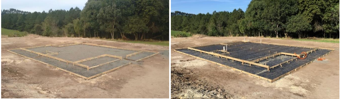
Figuras 33 e 34 – Fundação em radier: (a) detalhe da armadura; e (b) detalhe da tubulação de esgoto
