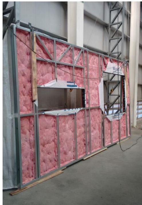
Figuras 23 e 24 – Instalação do isolamento em lã de vidro
