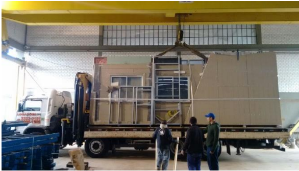
Figuras 41, 42, 43, 44, 45 e 46 – Descarregamento e montagem dos painéis na obra
