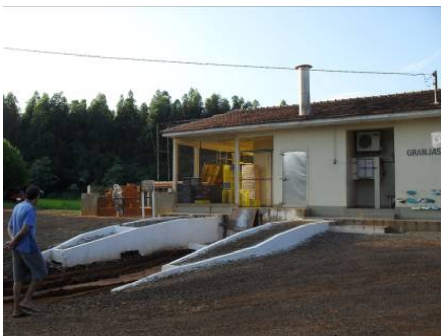
FIGURA 2 - Portaria de acesso ao núcleo de matrizes.
