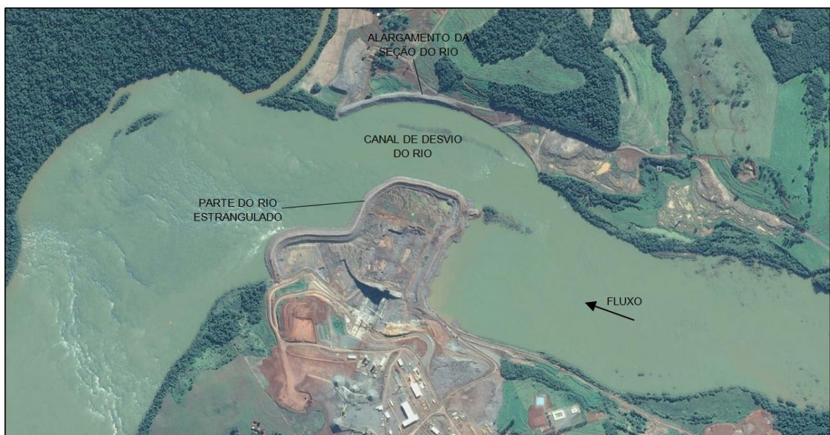
FIGURA 2.2 – ESQUEMA TÍPICO DE ALARGAMENTO DA CALHA ESTRANGULADA PARA DESVIO DO RIO POR CANAL NA OBRA DE BAIXO IGUAÇU NO RIO IGUAÇU, PARANÁ FONTE: Google Earth (2014)
