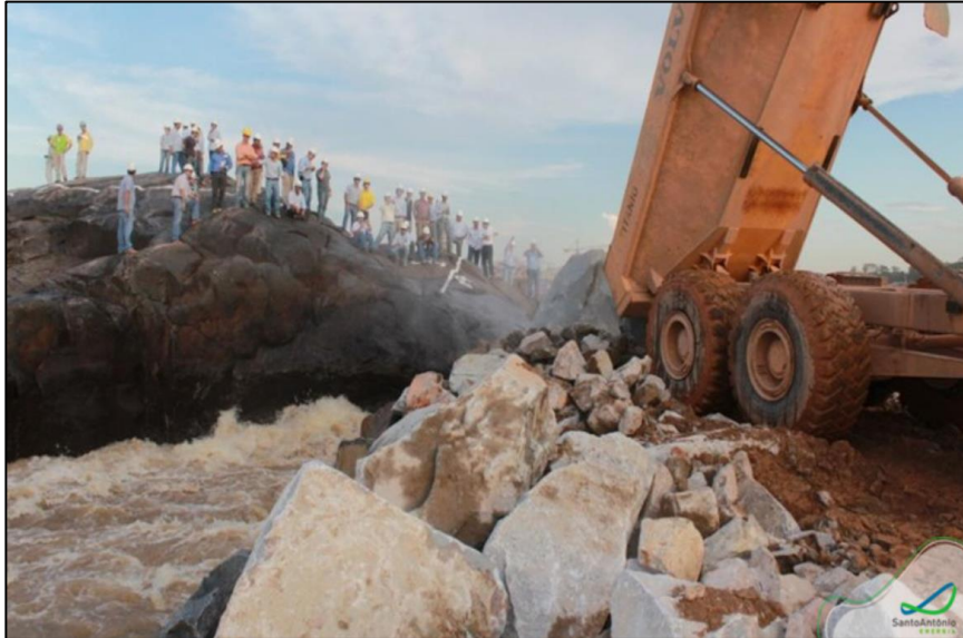
FIGURA 2.14 – CONCLUSÃO DO FECHAMENTO DO CORDÃO DE ENROCAMENTO DO LEITO DO RIO MADEIRA PARA A CONSTRUÇÃO DA UHE SANTO ANTÔNIO (PORTO VELHO – RONDÔNIA)
