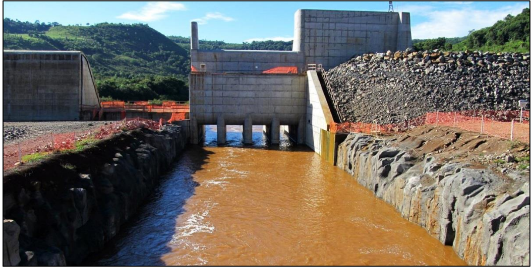
FIGURA 2.4 - DESVIO DO RIO ATRAVÉS DE ADUFAS DE DESVIO FONTE: Agência Estadual de Notícias (2014)
