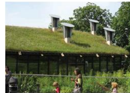
Exemplo do telhado verde no museu Horniman, Londres.
