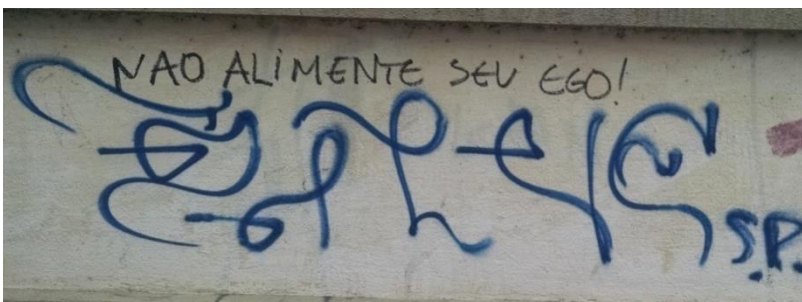
Figura 52 - Intervenções no prédio da Unespar da Rua Emiliano Perneta. (Foto: L. H. Oliveira, 2015).
