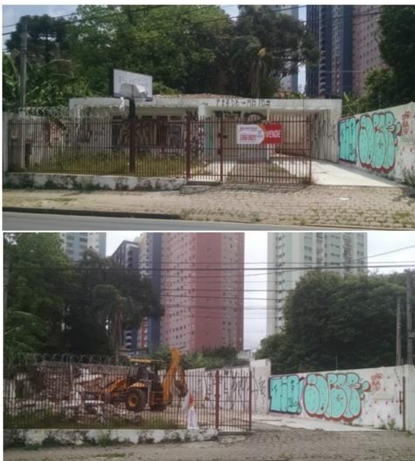
Figura 65 - Casa vazia coberta por intervenções antes e durante a demolição. (Foto: L. H. Oliveira, 2015).
