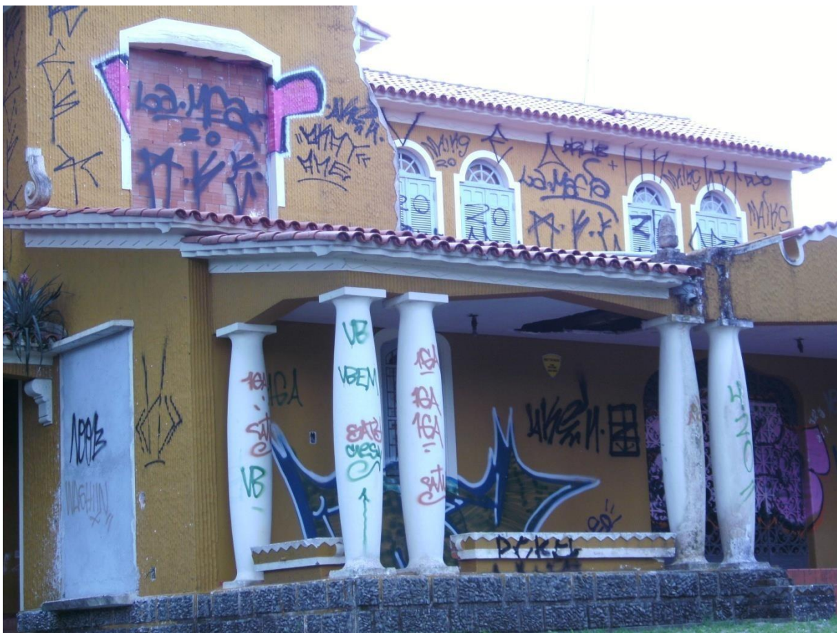
Figura 67 - Casa abandonada na Rua Padre Antônio. (Foto: L. H. Oliveira, 2011).
