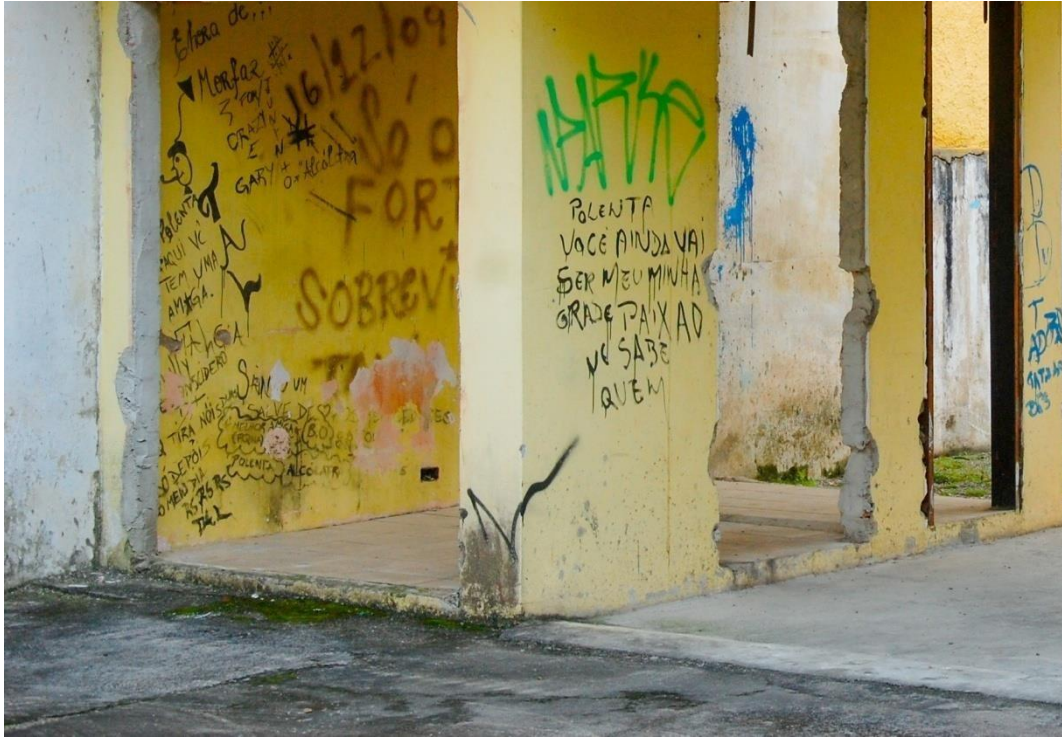
Figura 47 - Intervenções em terreno na Rua Benjamin Constant. (Foto: L. H. Oliveira, 2015).
