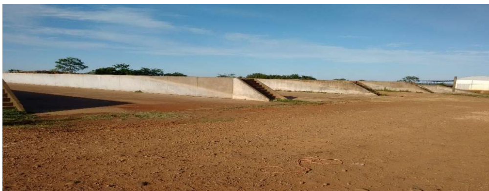
Figura 5 - Silos do tipo trincheira para armazenamento de forragem conservada.
