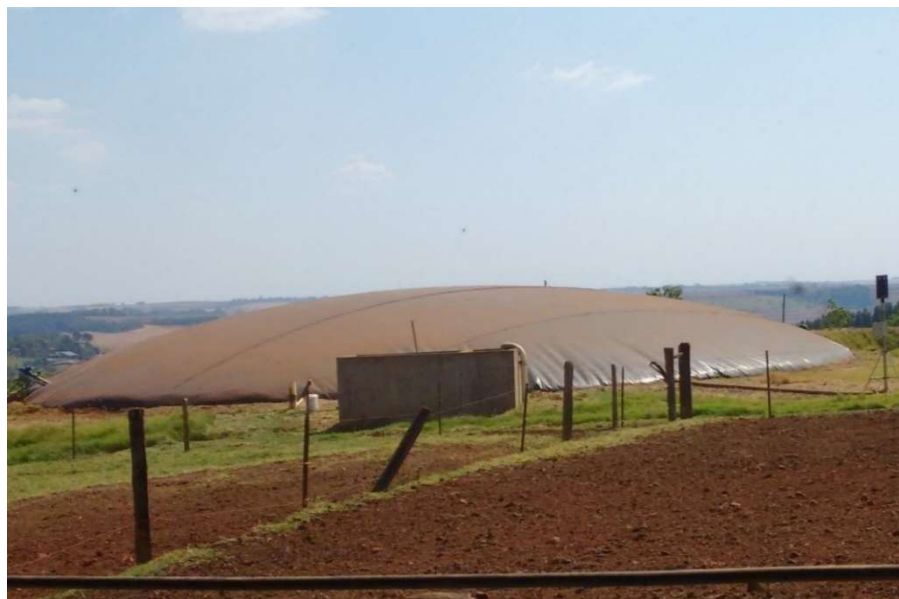
Figura 8 - Biodigestor.
