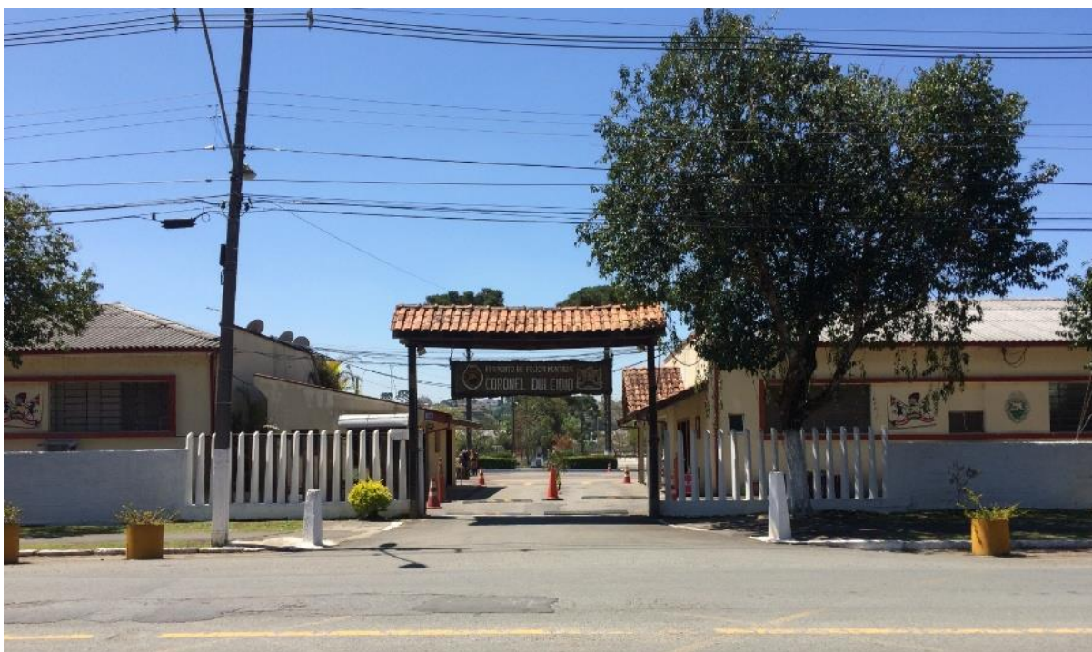
Figura 03. Fachada Regimento de Polícia Montada Coronel Dulcídio Curitiba-PR, 2016. Local aonde foi realizado segunda parte do estágio obrigatório. (Fonte:Wanessa Kruger)
