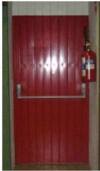
Figura 45 – Saída de emergência
