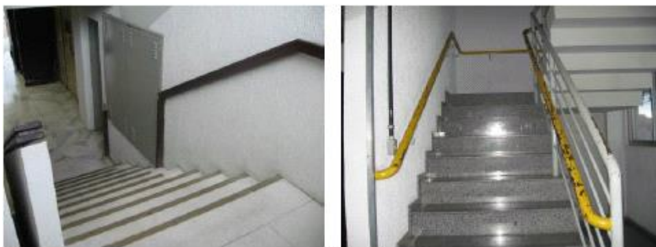
Figura Figuras 39 e 40 – Escadas internas
