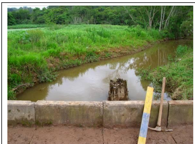
Figura 9: Córrego Luzitano antes da execução das obras de implantação de rede coletora de esgoto - Bairro: Jd. Luzitano - Ribeirão Pires (Fonte: Consórcio DP Barros/Geva)
