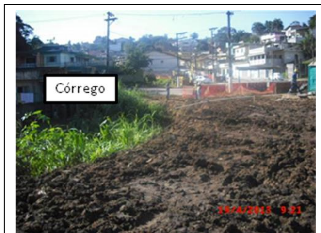
Figura 7: Evidência de carregamento de solo para o sistema de drenagem de esgoto e águas pluviais (córrego) - São Bernardo do Campo (Fonte: Consórcio DP Barros/Geva)
