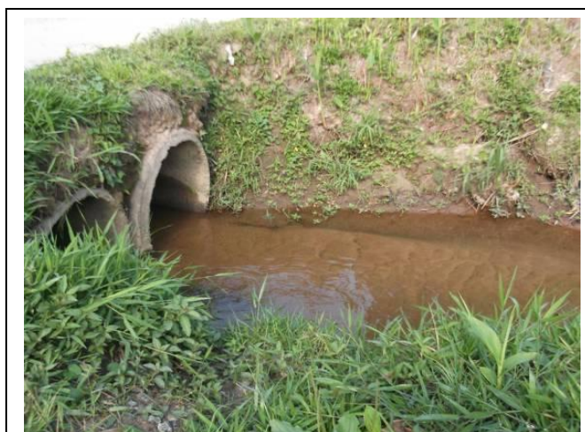
Figura 10: Córrego Luzitano após a execução das obras de implantação de rede coletora de esgoto - Bairro: Jd. Luzitano - Ribeirão Pires (Fonte: Consórcio DP Barros/Geva).
