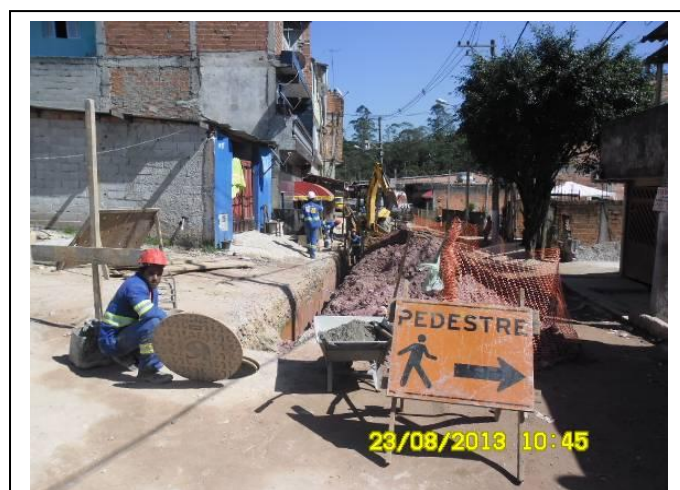
Figura 14: Rua Quitéria Ana Leite da Silva - Bairro Capelinha - Riacho Grande - SBC. Situação da rua durante a realização da obra (Fonte: Consórcio DP Barros/Geva).
