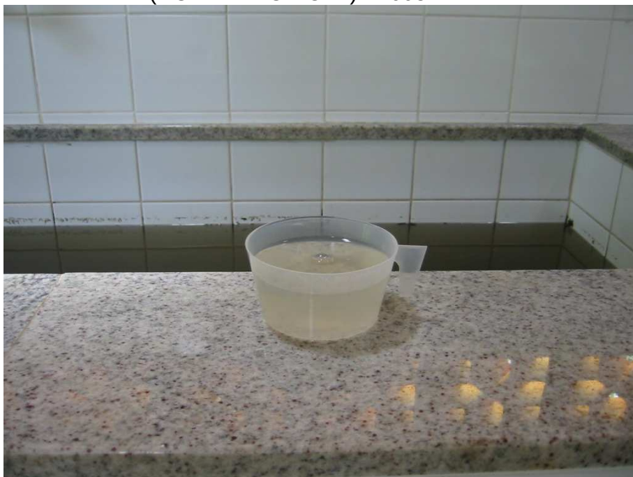
FIGURA 26 – FASE SECUNDÁRIA DE TRATAMENTO (INÍCIO DA CLORAÇÃO) (HOTEL TROPICAL) - 2005
