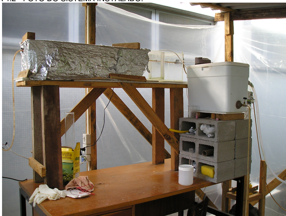
FIGURA 4.2 - FOTO DO SISTEMA INSTALADO.
