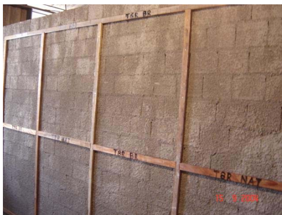
Figura 11 – Vista dos painéis prontos para o revestimento
