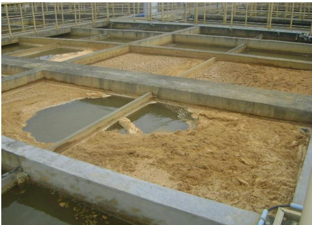
Figura 3 - Tanque de decantação após o processo de Floculação das sujeiras, incluindo argila.
