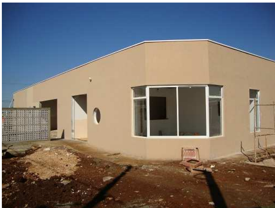
Foto 12 – Assentamento de Esquadrias, e acabamento externo, com muro de cobogó
