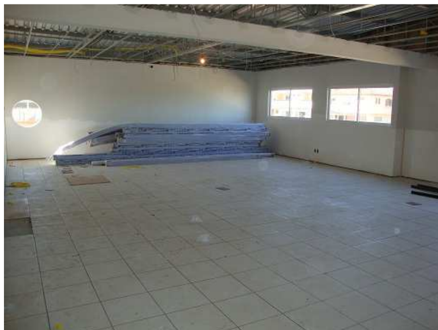
Foto 14 – Vista das salas ainda unificadas, com o forro de PVC a ser instalado.
