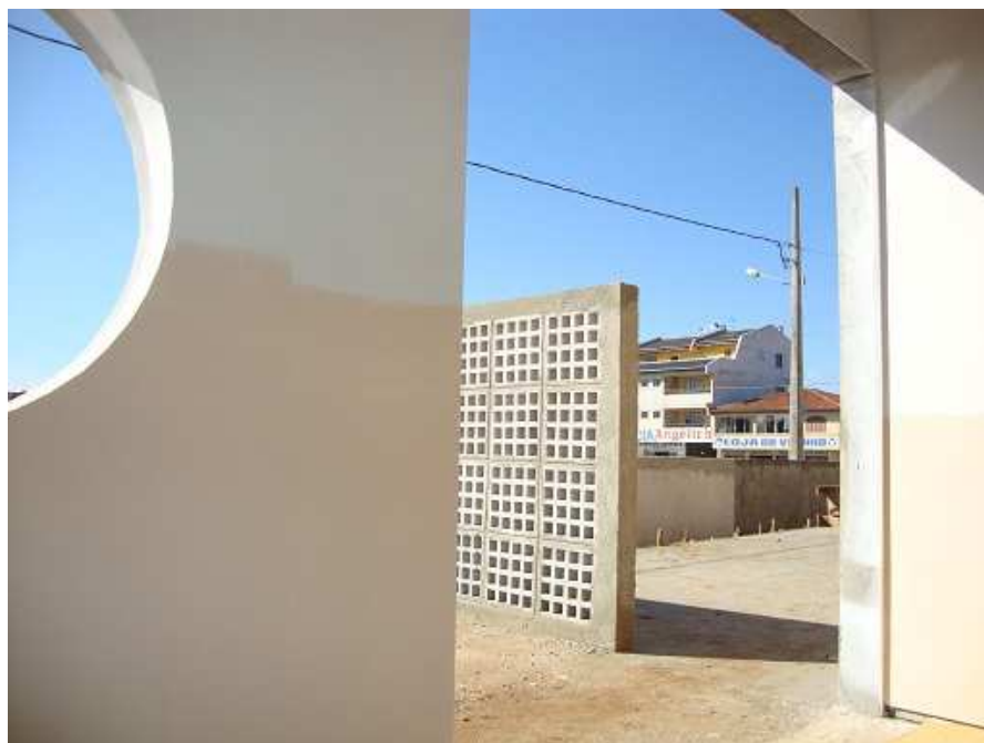
Foto 13 - Pintura sobre revestimento de placas de gesso acartonado; colocação de vidros.
