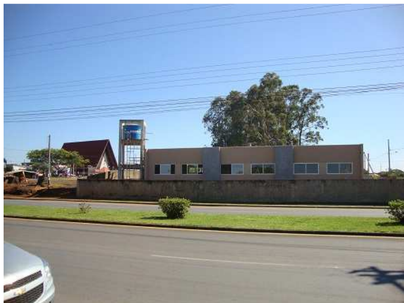
Foto 15 e 16 – Aspecto da vista externa com a obra praticamente acabada.
