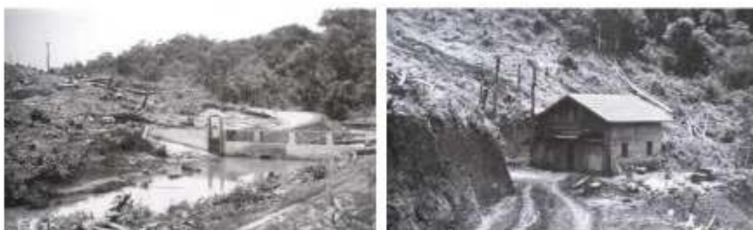
Figura 8: Construção da Usina Cambézinho (para o lago do Parque Arthur Thomas) e a barragem e casa de máquinas. Fonte: Zuliani em Museu de Londrina (2016).
