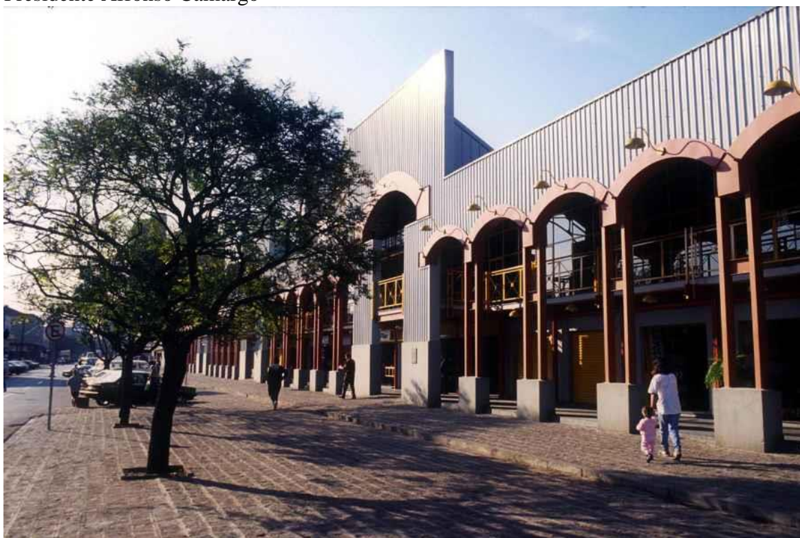
Figura 8 – Painéis metálicos instalados nas fachadas da Rua General Carneiro e da Av. Presidente Affonso Camargo
