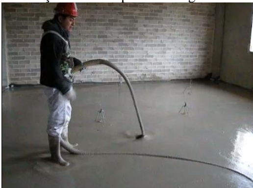
Figura 1.1 - Execução de contrapiso com argamassa autonivelante.
