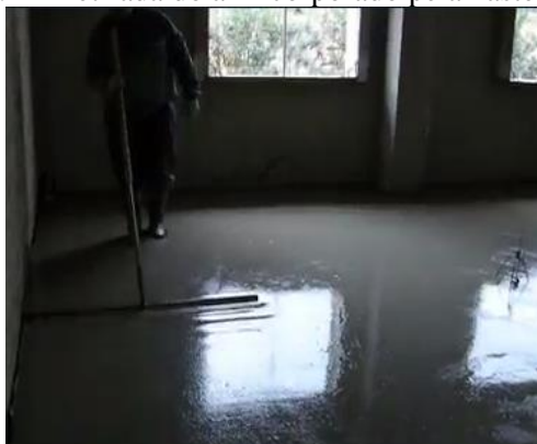
Figura 1.2 – Retirada do ar incorporado pela haste de metal.
