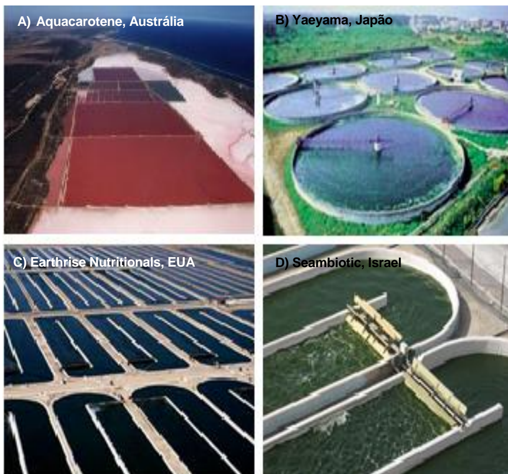
FIGURA 3 - SISTEMAS ABERTOS PARA CULTIVO DE MICROALGAS; A) LAGOAS; B) TANQUES CIRCULARES; C) SISTEMA RACEWAYS; D) DETALHE DAS PAS DE AGITAÇÃO EM RACEWAYS.
