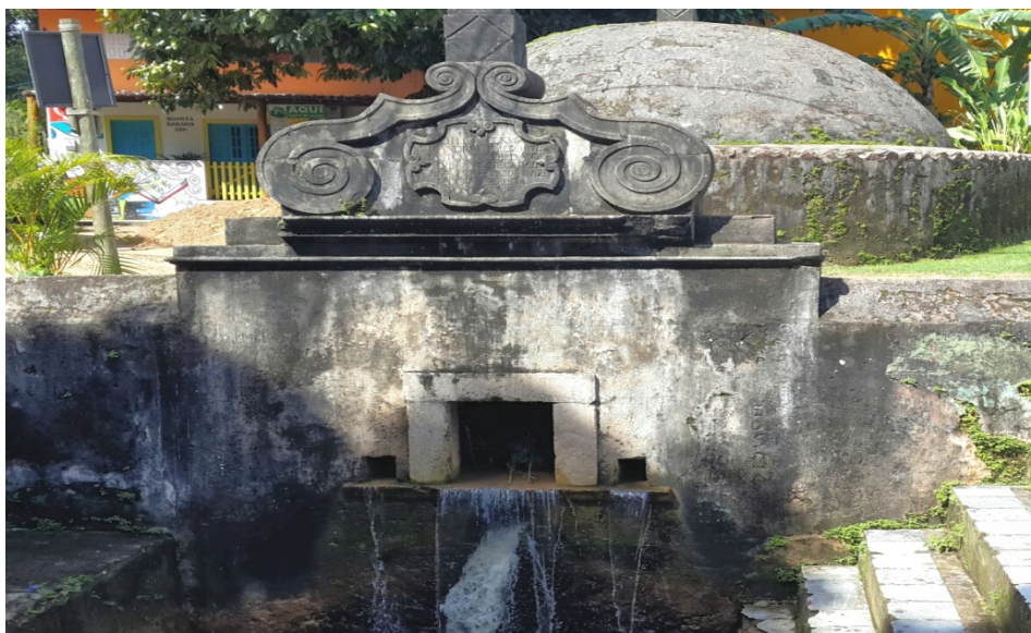
Figura 2 - Sistema de abastecimento de água no período colonial, Fonte Grande - BA Fonte: o Autor (2014)
