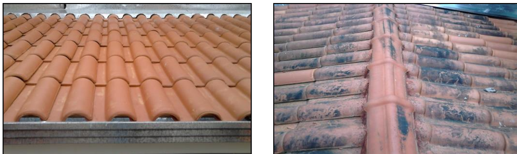
Figura 14 – Telhados com dois meses de instalação (à direita) e com 16 meses de instalação (à esquerda) - Bairro Tarumã – Curitiba.
