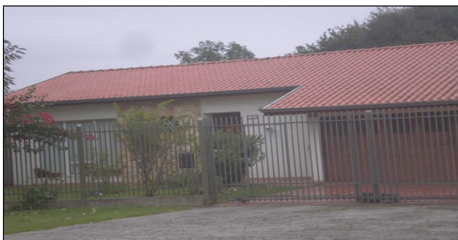
Figura 08 - Cobertura com telhas cerâmicas – Bairro Tarumã – Curitiba.
