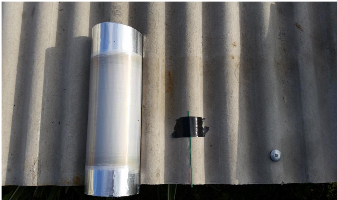
Figura 34 – Termopar instalado na superfície da telha de fibrocimento – antes da proteção.
