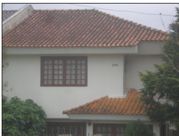
Figura 13 – Telhado com mais de 10 anos de instalação - Bairro Tarumã – Curitiba.
