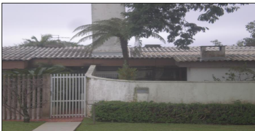
Figura 09 - Cobertura com telhas de fibrocimento – Bairro Tarumã – Curitiba.
