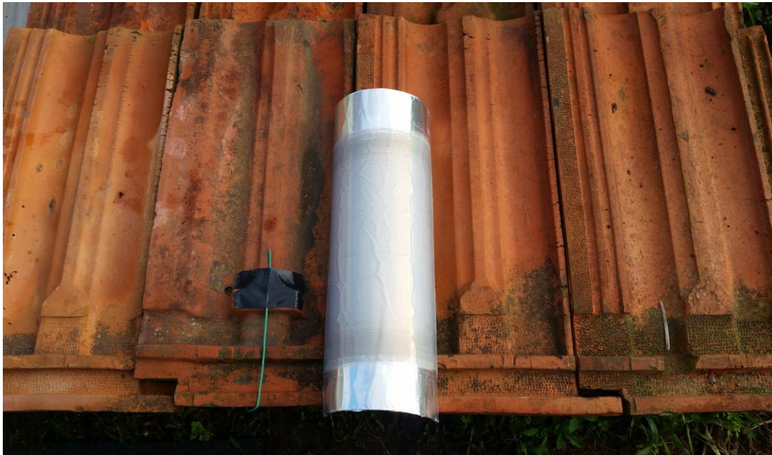
Figura 32 – Termopar instalado na superfície da telha cerâmica – antes da proteção.
