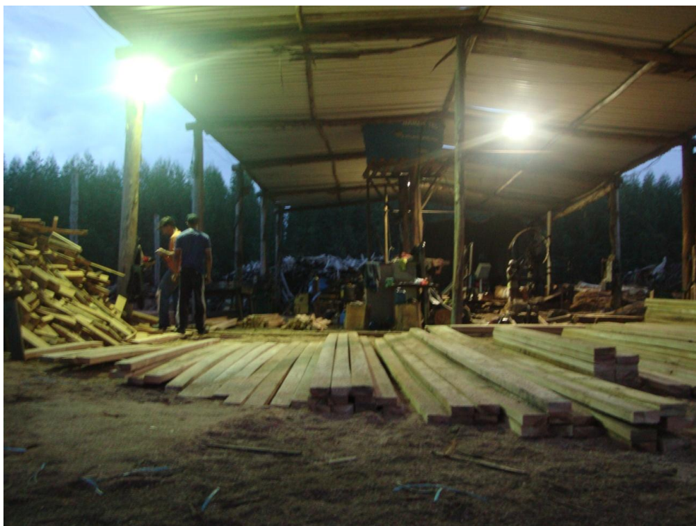
FOTO 4 - ESTALEIRO INTERNO, PRODUÇÃO DE VIGAS, FIM DO DIA DE TRABALHO (2). FONTE: O autor (2013)
