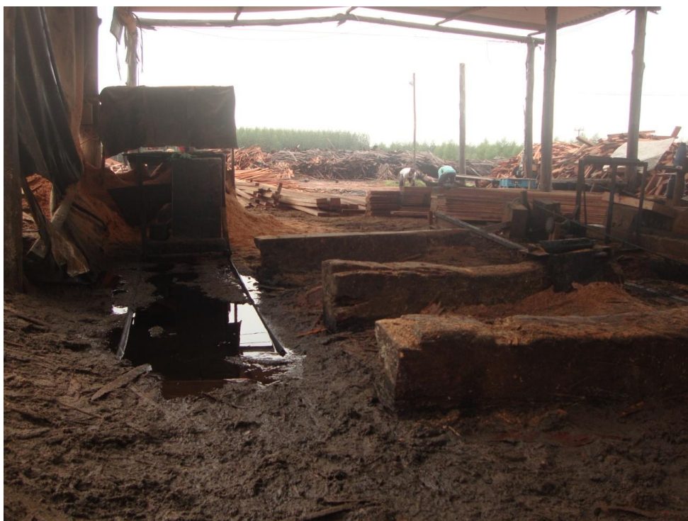
FOTO 52 - PROBLEMAS DE DRENAGEM NO INTERIOR DA SERRARIA. RISCO DE ACIDENTE EMINENTE. FONTE: O autor (2013)
