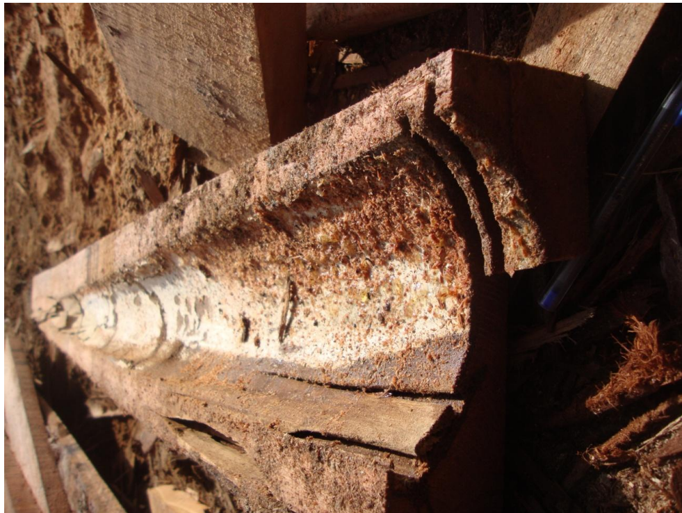
FOTO 14 - PARTE CENTRAL DA TORA BIODEGRADADA, APÓS O DESDOBRO (1). FONTE: O autor (2013)
