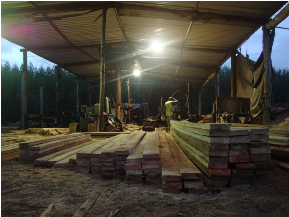
FOTO 3 - ESTALEIRO INTERNO, PRODUÇÃO DE VIGAS, FIM DO DIA DE TRABALHO (1). FONTE: O autor (2013)
