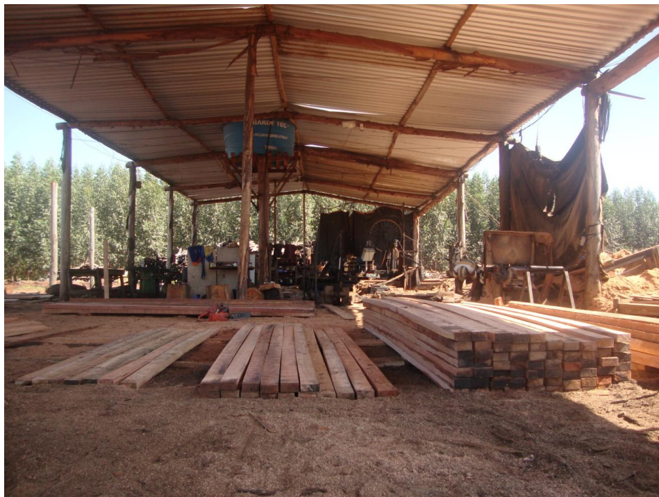
FOTO 7 - ESTALEIRO INTERNO, PRODUÇÃO DE VIGOTAS, MEADOS DO PERÍODO DA MANHÃ. FONTE: O autor (2013)
