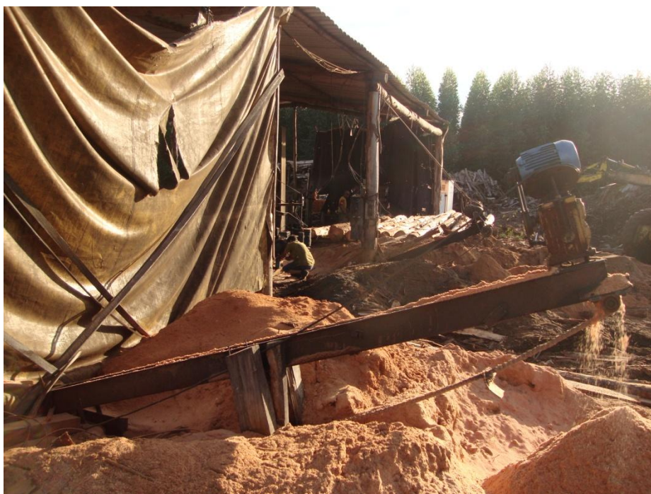
FOTO 30 - ESTEIRA TRANSPORTADORA DE SERRAGEM DA SERRA CIRCULAR. MAL DIMENSIONADA PARA DESEMPENHAR A FUNÇÃO DE MANEIRA SATISFATÓRIA.
