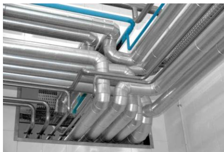
Figura 18 – Linha de água gelada. Fonte: (Site Maranata montagem industrial).
