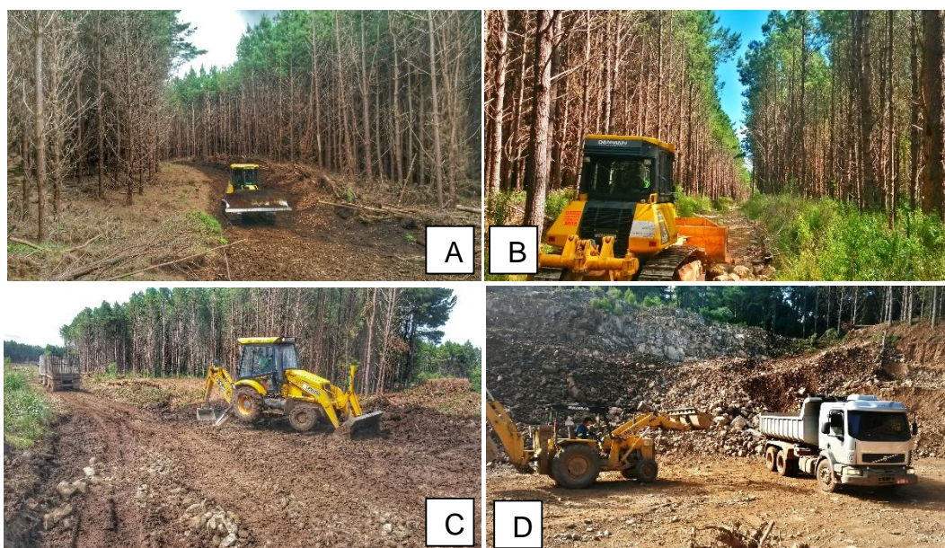
FIGURA 2 A- MANUTENÇÃO DE RAMAL; B - MANUTENÇÃO DE ESTRADA CASCALHADA; C - ESPALHAR CARGA DE CASCALHO (ALTERAÇÃO DE COEFICIENTE DE COMPACTAÇÃO DA VIA); D - CARREGAMENTO E TRANSPORTE DE CASCALHO.
