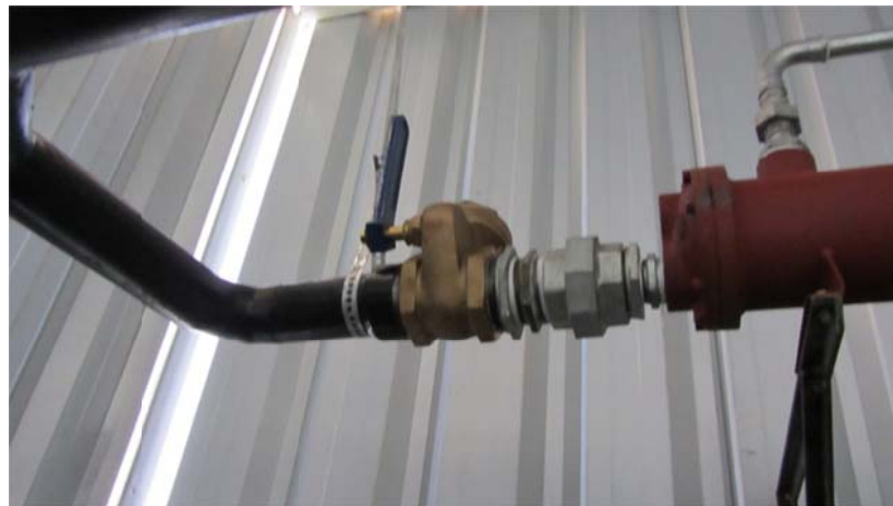
FIGURA 3.18 VÁLVULA DIRECIONAL
