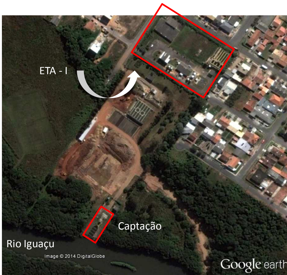
FIGURA 3.1 – FOTO DA LOCALIZAÇÃO DA ETAI
