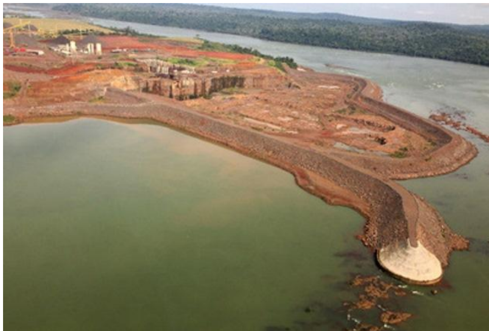
Figura 11: Imagem do canteiro de obras da UHE Baixo Iguaçu antes do rompimento das ensecadeiras. 173
