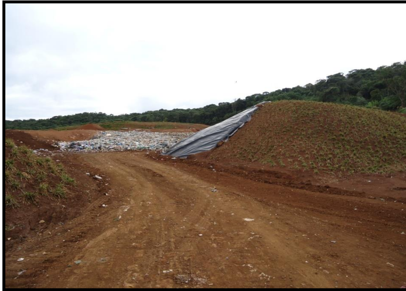
FIGURA 7 – ATERRO SANITÁRIO DE UNIÃO DA VITÓRIA FONTE: A AUTORA, 2012
