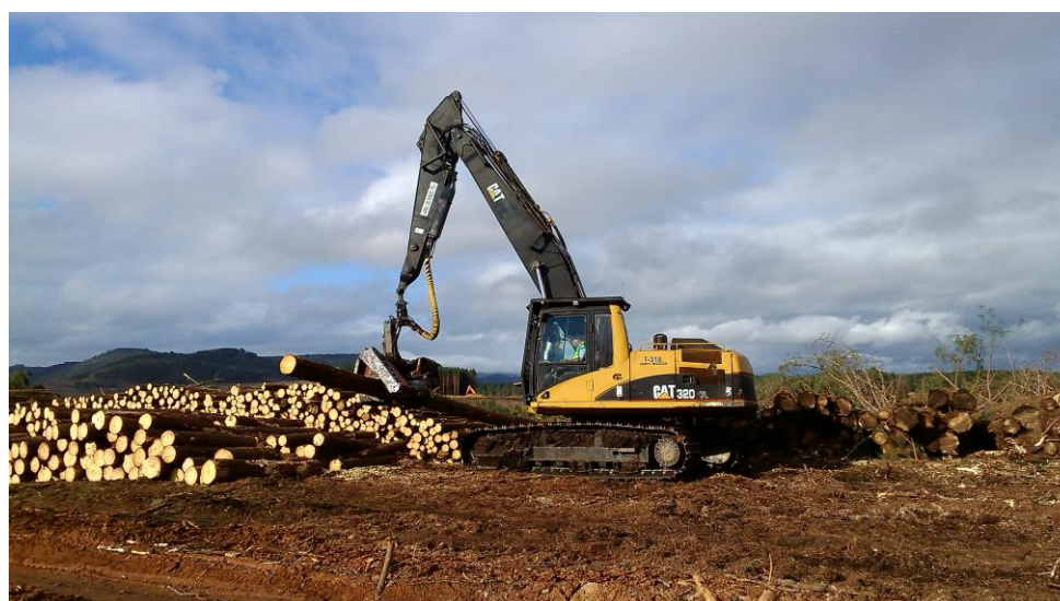
Figura 2. Escavadeira CAT 320CL.
