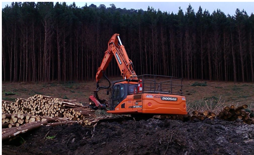
Figura 1. Escavadeira Doosan DX225LCA.
