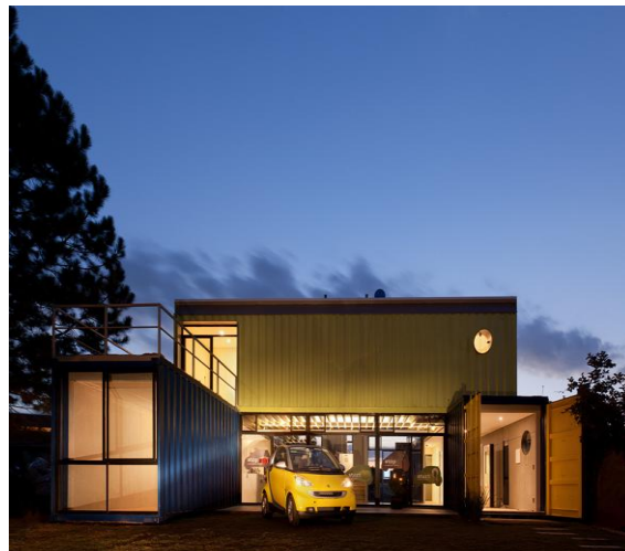
Figura 6. Casa Container depois da Adaptação ( Retirado do Site: Projeto Casa Container )
