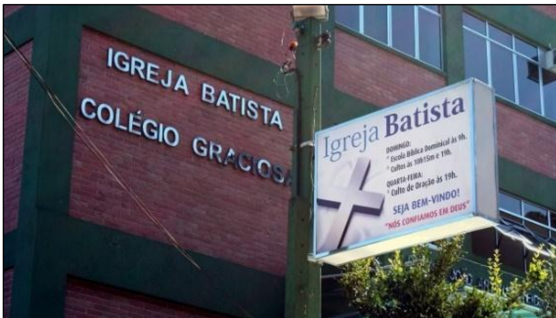
FIGURA 6- FOTOGRAFIA DA FACHADA DO COLÉGIO GRACIOSA ATUALMENTE – QUATRO BARRAS-PR.
