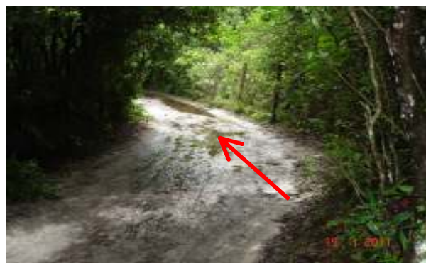
FIGURA 26 - Alagamento na trilha de acesso ao Farol FONTE: Dados de Pesquisa
