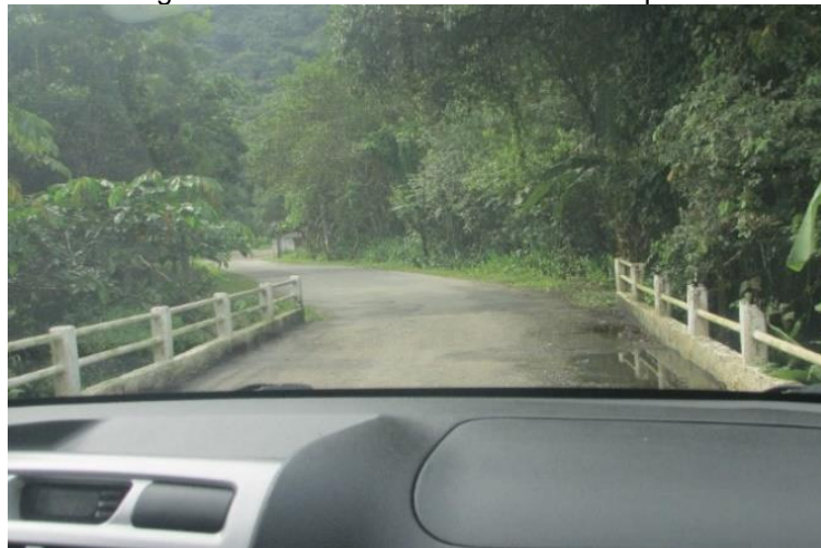
Figura 17: Ponte no acesso ao Cabaraquara
