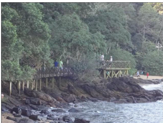
FIGURA 22 – Passarela de acesso à Praia do Canto FONTE: A autora
