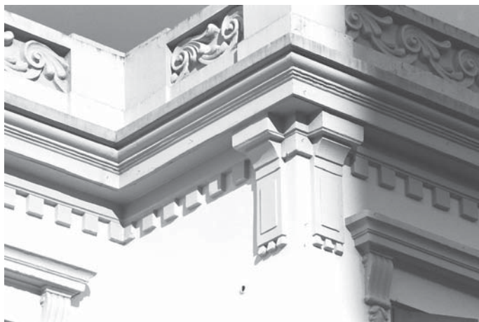
↑ Foto 91: DETALHE DA PLATIBANDA Fonte: CASTRO, 2004.
