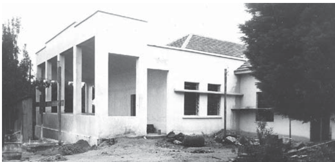
↓ Foto 94: VISTA PARCIAL DO PAVILHÃO PARA TUBERCULOSOS Fonte: CORDENADORIA DO PATRIMÔNIO DO ESTADO
