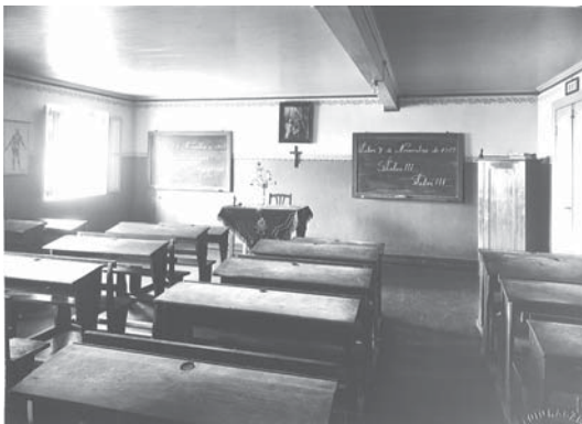
↓ Foto 75: SALA DE AULA Fonte: ASILO SÃO VICENTE DE PAULO. Sem data.
