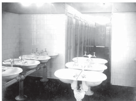
↓ Foto 58: SANITÁRIO COLETIVO
