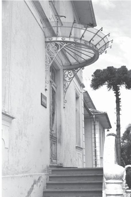
← Foto 67: DETALHE DO ACESSO PRINCIPAL Fonte: CASTRO, 2004.
