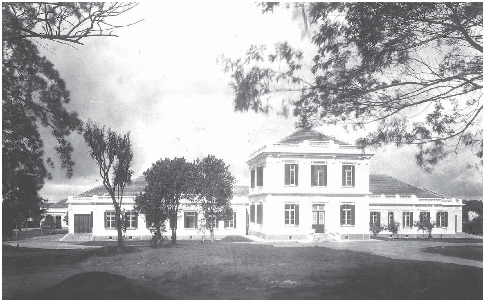
↑Foto 90: VISTA GERAL DO PAVILHÃO PRINCIPAL Fonte: COORDENADORIA DO PATRIMÔNIO DO ESTADO. Sem data.
