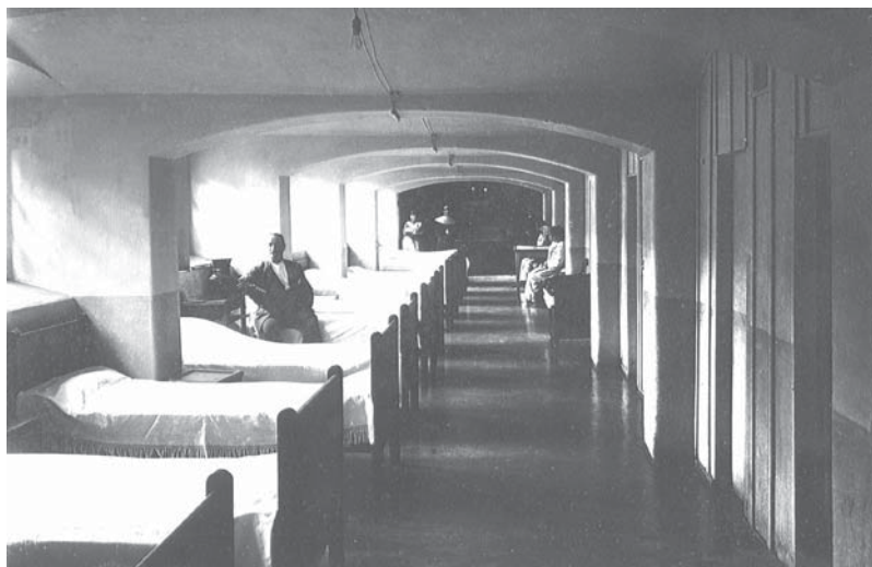
↑ Foto 03: PAVILHÃO DE INTERNAMENTO - Térreo - Enfermarias
