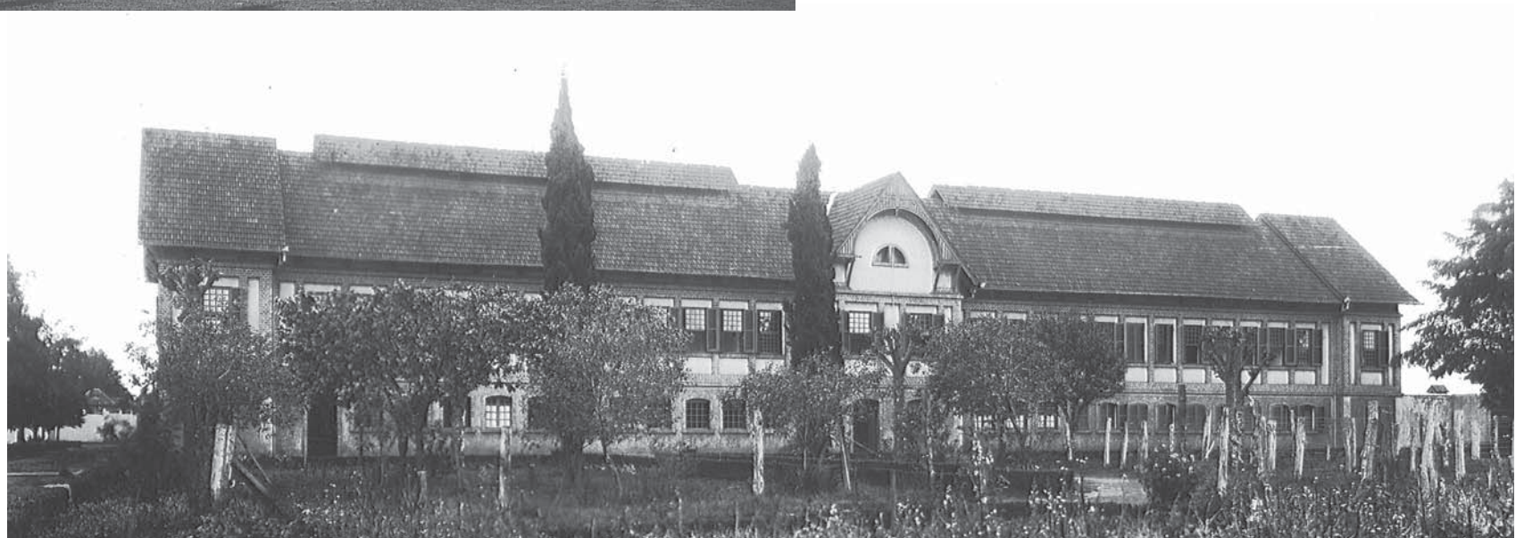
↓ Foto 02: PAVILHÃO DE INTERNAMENTO - Vista Frontal Fonte: SETOR DE INFRA-ESTRUTURA DA PUC. SEM DATA.
