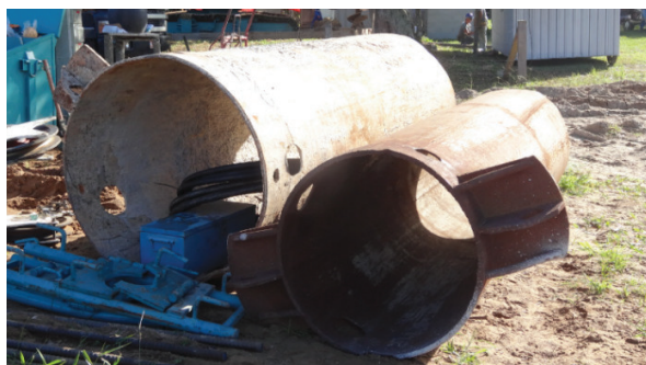
Figura 3.6 - Camisas metálicas usadas nas estacas teste com 120 e 90 cm de diâmetro.
