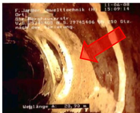
FIGURA 19 – LIGAÇÃO LATERAL APÓS A APLICAÇÃO DA REPARAÇÃO
