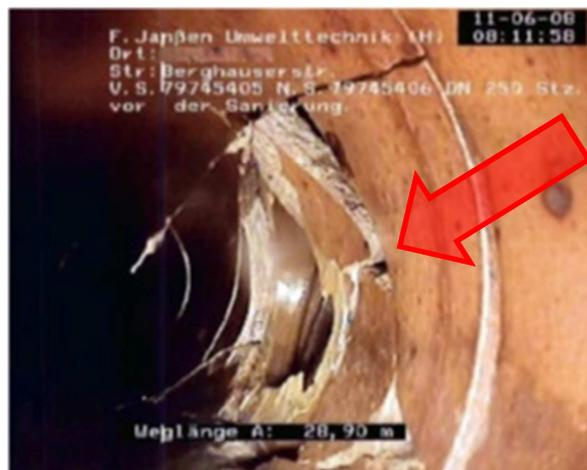
FIGURA 18 – LIGAÇÃO LATERAL ANTES DA APLICAÇÃO DA REPARAÇÃO
