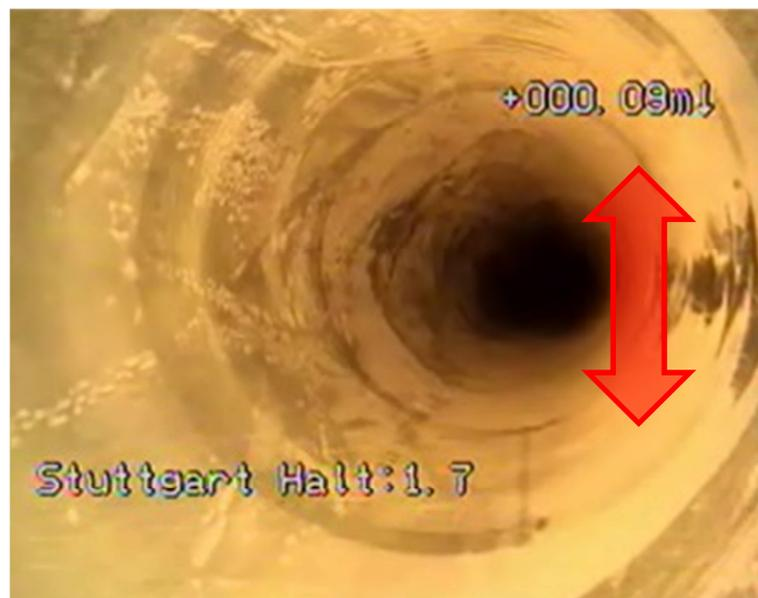
FIGURA 21 – REDE APÓS APLICAÇÃO DA RENOVAÇÃO
