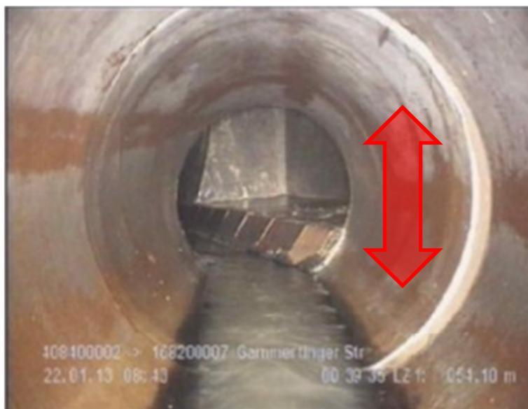
FIGURA 24 – REDE EXSITENTE COM DN 500 MM A SER ABANDONADA
