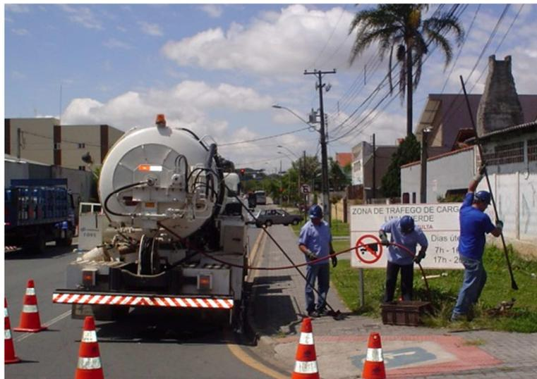
FIGURA 37 – EQUIPE DE LIMPEZA COM CAMINHÃO DE HIDROJATO
