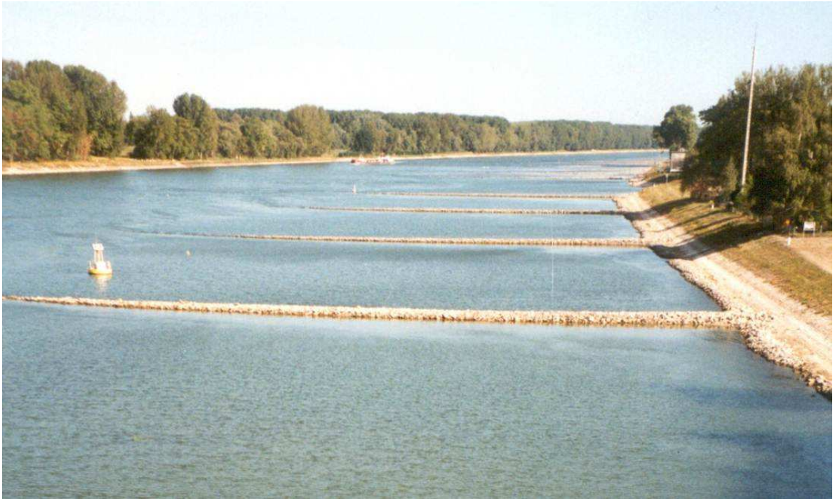
Figura 2.12 – Espigões de enrocamento (WEITBRECHT, 2004).
