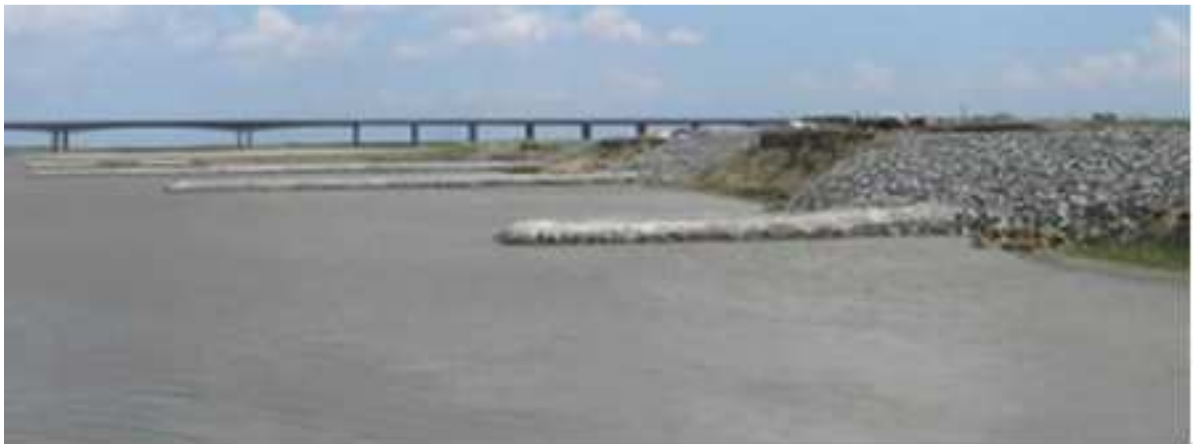
Figura 2.12 – Espigões de enrocamento (WEITBRECHT, 2004).
