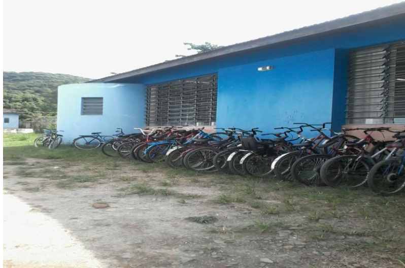
FOTO 2: Lateral da Biblioteca localizada ao lado direito do colégio. FONTE: a autora, 2014.
