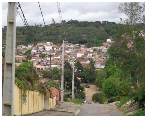
FOTOGRAFIA 22 - ÁREA DE VULNERABILIDADE
